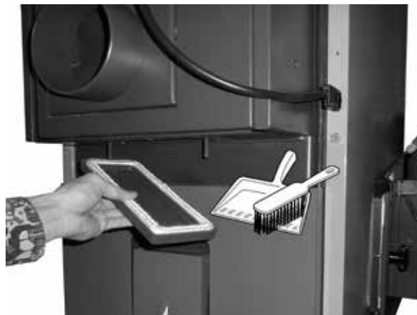
Exemplu de curățare canal de fum în partea posterioară cazanului
