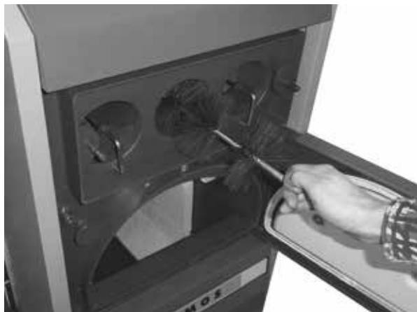
Curățarea schimbătorului (plăcilor tubulare) cu perie (la cazanul D20P, D30P, D40P și D50P)
